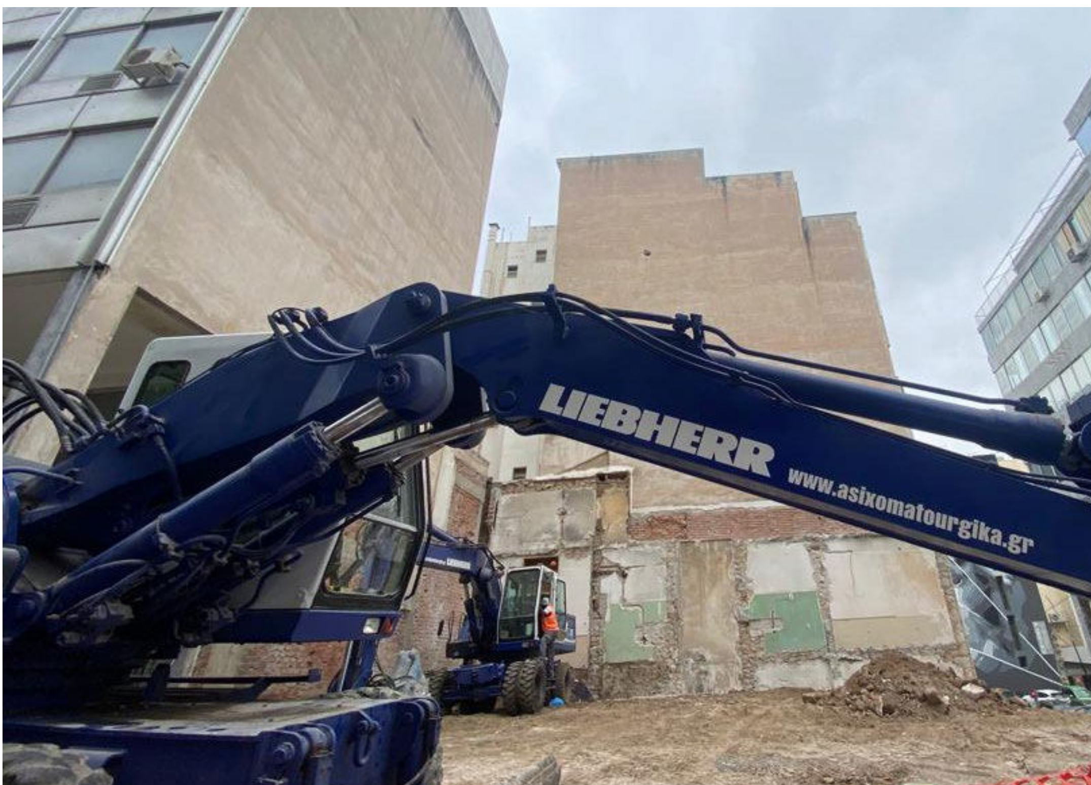
ТЕКУЩЕЕ СОСТОЯНИЕ ПРОВОДИМЫХ РАБОТ
